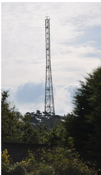
Radio mast at Bawdsey
