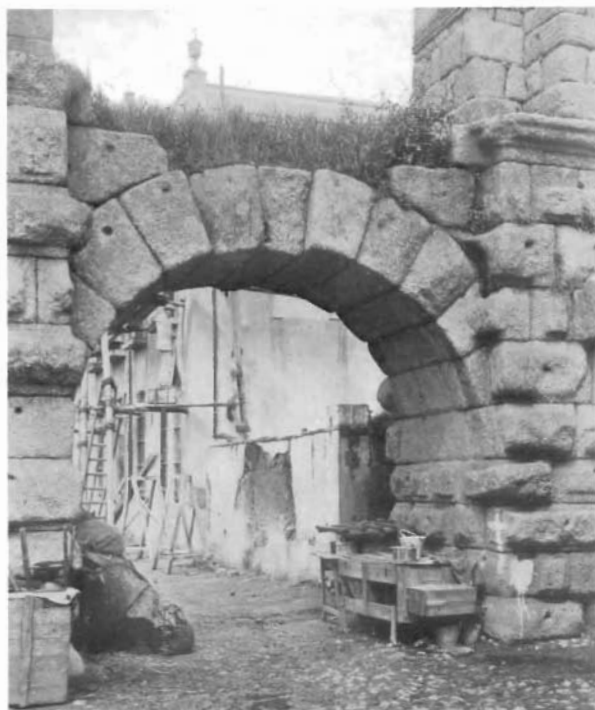
B. ACUEDUCTO DE SAN LÁZARO, MÉRIDA Note the bonding of voussoirs with coursed masonry
