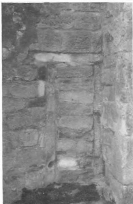
B. Escomb, blocked N. door of chancel
