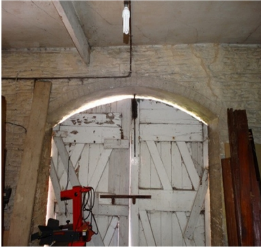
Plate 7 : Inside the Coach House : Double Doors...01.08.16.
