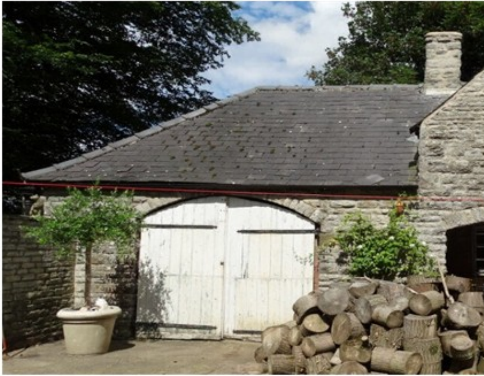
Plate 1 : Coach House : South Side...01.08.16.
