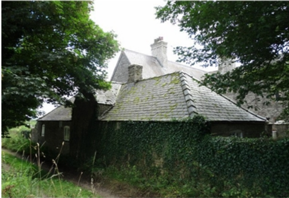
Plate 3 : Coach House North Side : 01.08.16.
