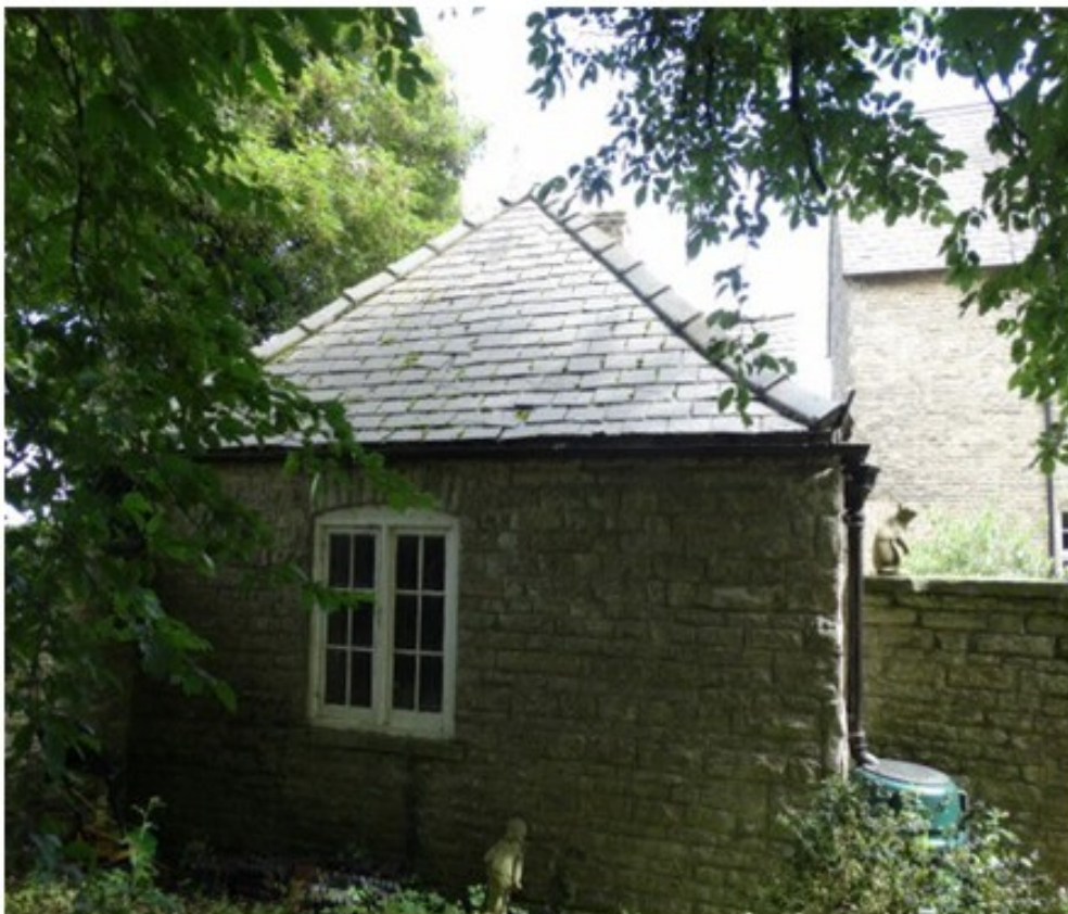
Plate 2 : Coach House : West Side...01.08.16.
