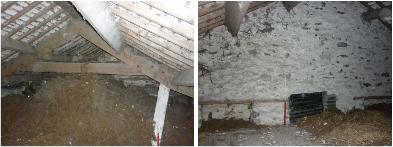
Plate 24 (left): Truss in F1
