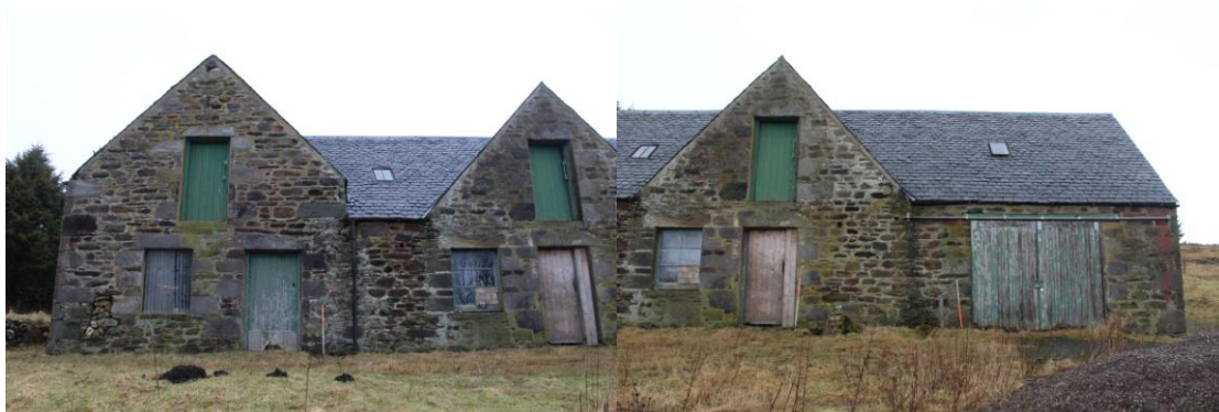
SW end of SE elevation
