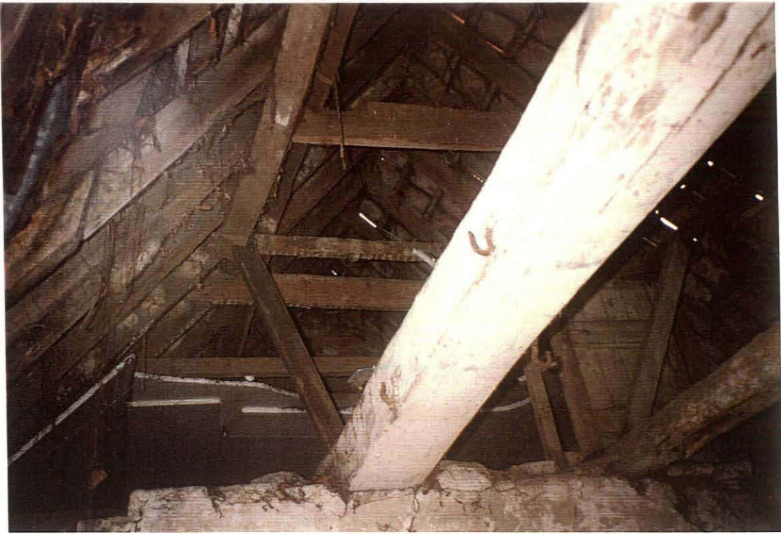
P. 3 Garage roof, looking N.
