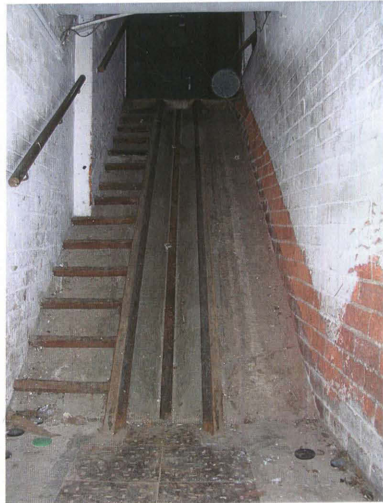
Pl. 38 The barrel chute
