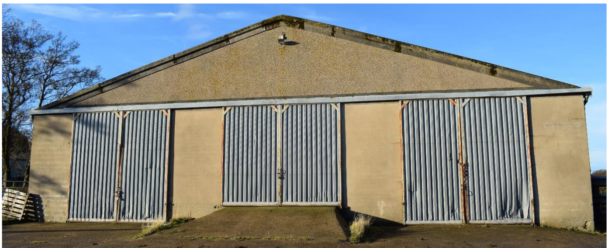
Illus 26 Building 6 SE wall D18, D19, D20; facing NW
