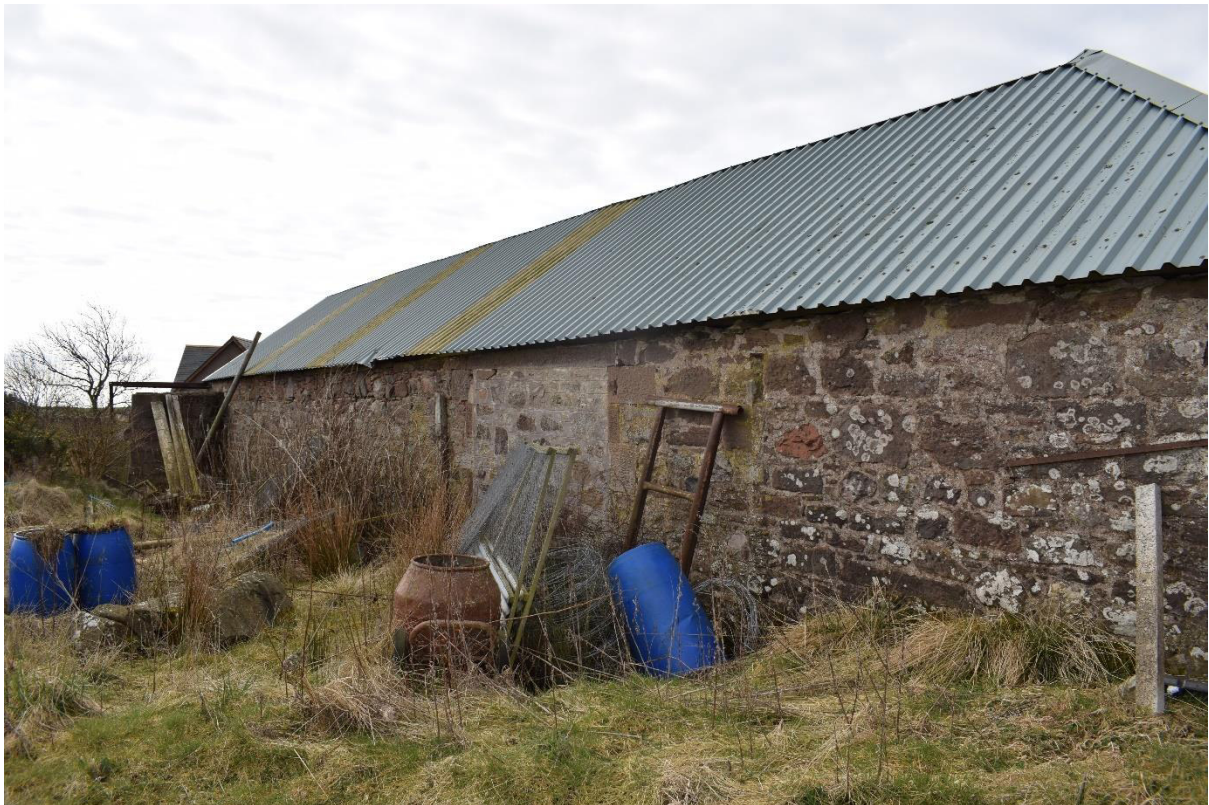
Illus 11 NE range NE wall NW end D8 (centre); facing S
