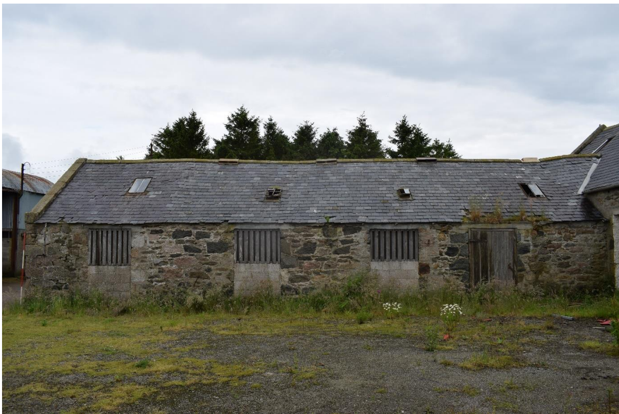
Illus 12 Building 4 W wing ESE wall D17, D16, D15, D14; facing WNW
