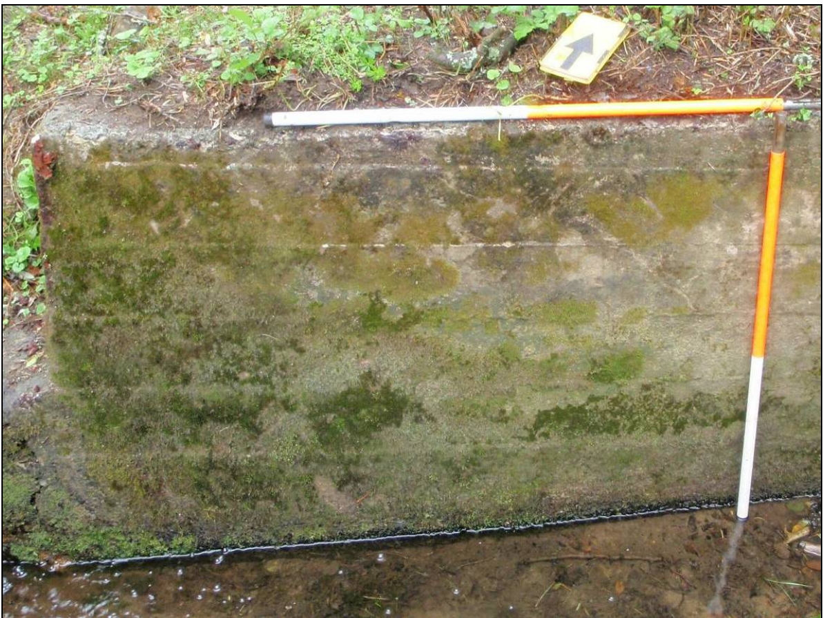
Fig 8 Detail of shutter pour wall construction
