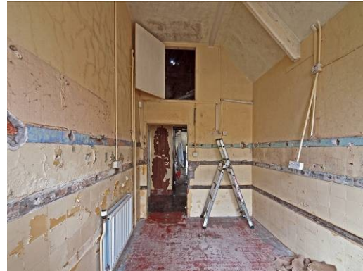
Fig 46: Room 4e looking west
