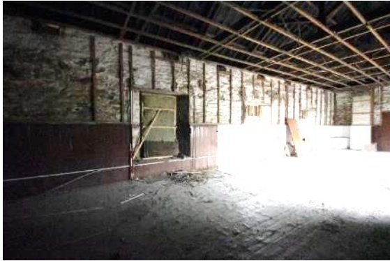
Fig 128 F1 south east wall.
