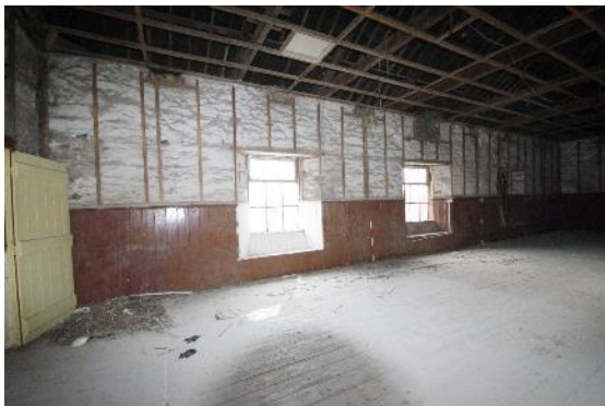
Fig 126 F1 north west wall.
