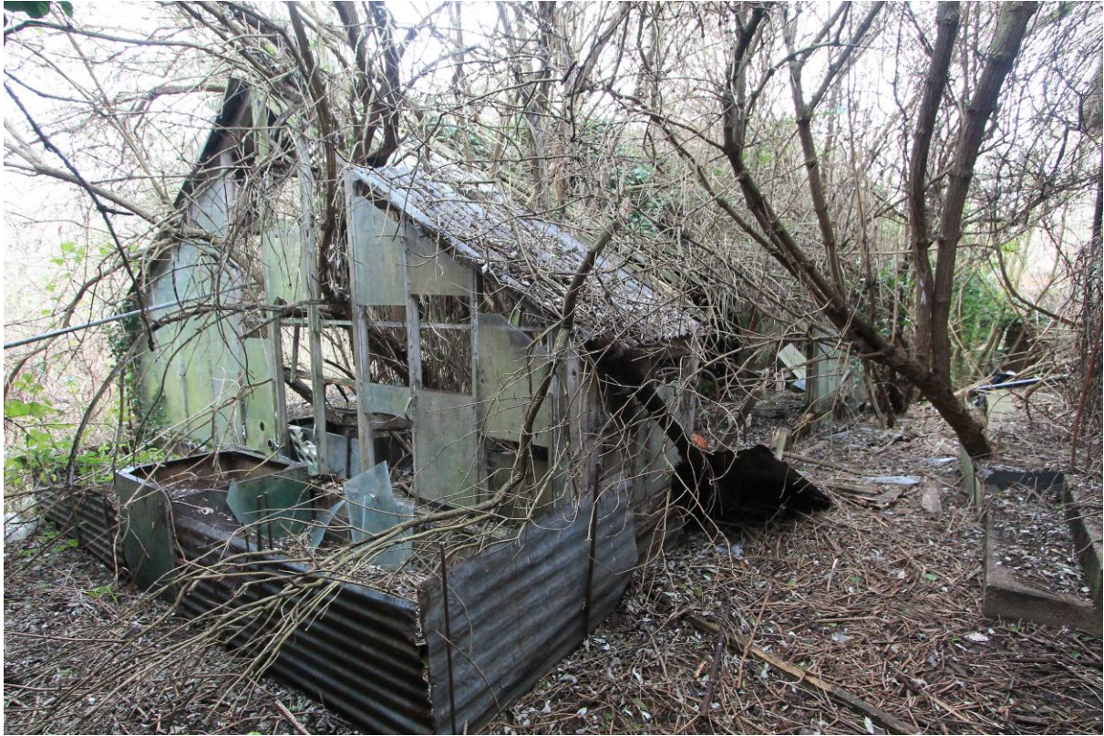
Plate 41 Glass-house (D) looking SW
