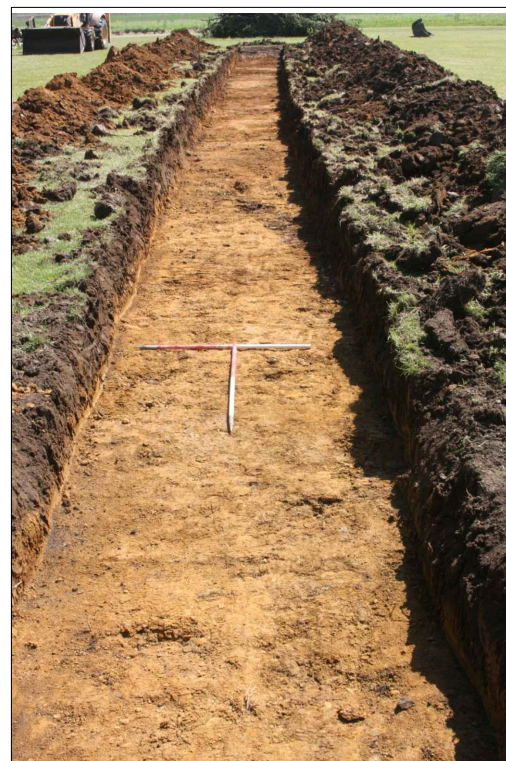
DP 2 - Trench 3, view SE
