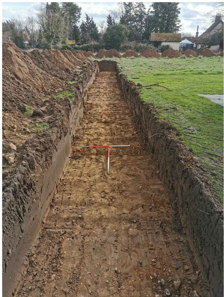
DP4 - TRENCH 2 - VIEW SE
