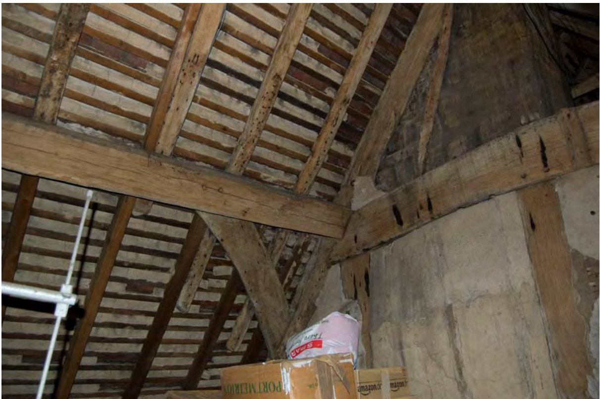
Fig 47: Windbrace
