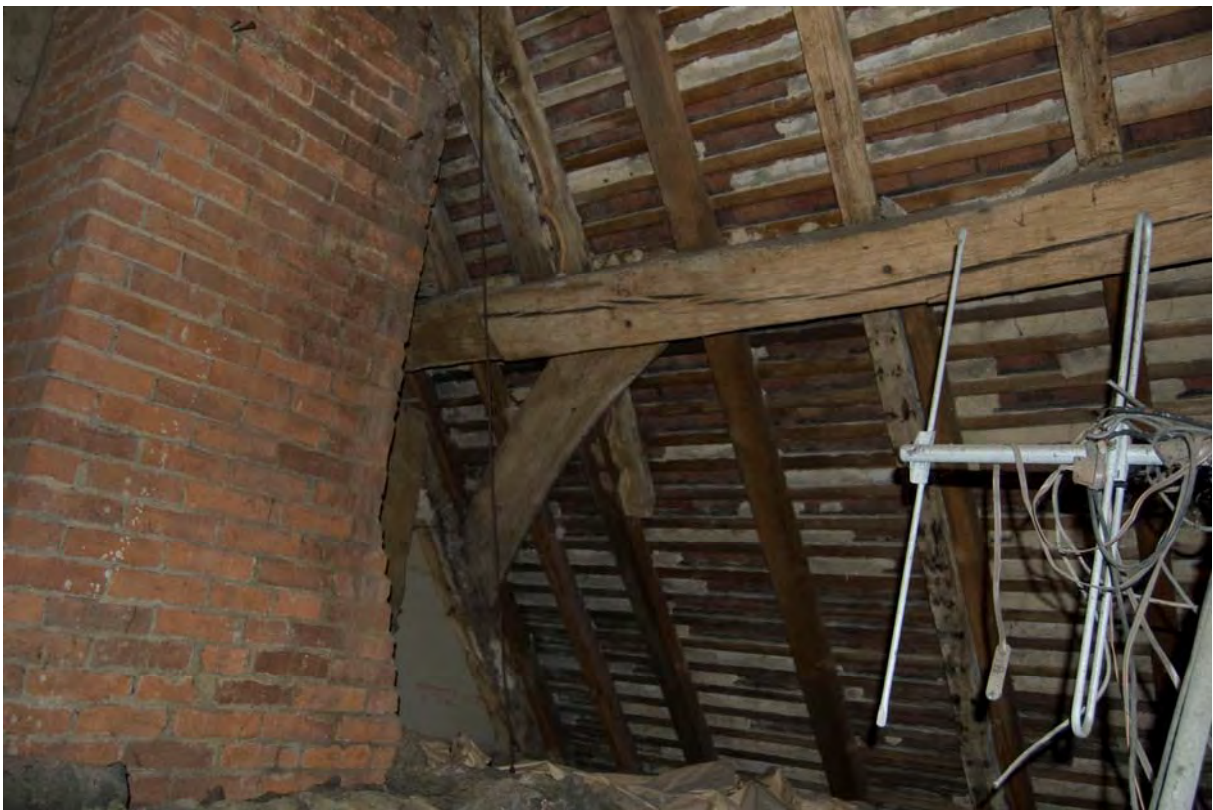
Fig 45: Windbrace
