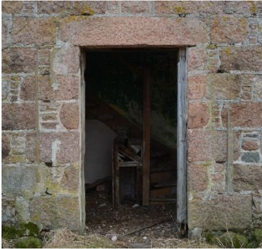
Illus 7 (LHS). Building 1. D1.
