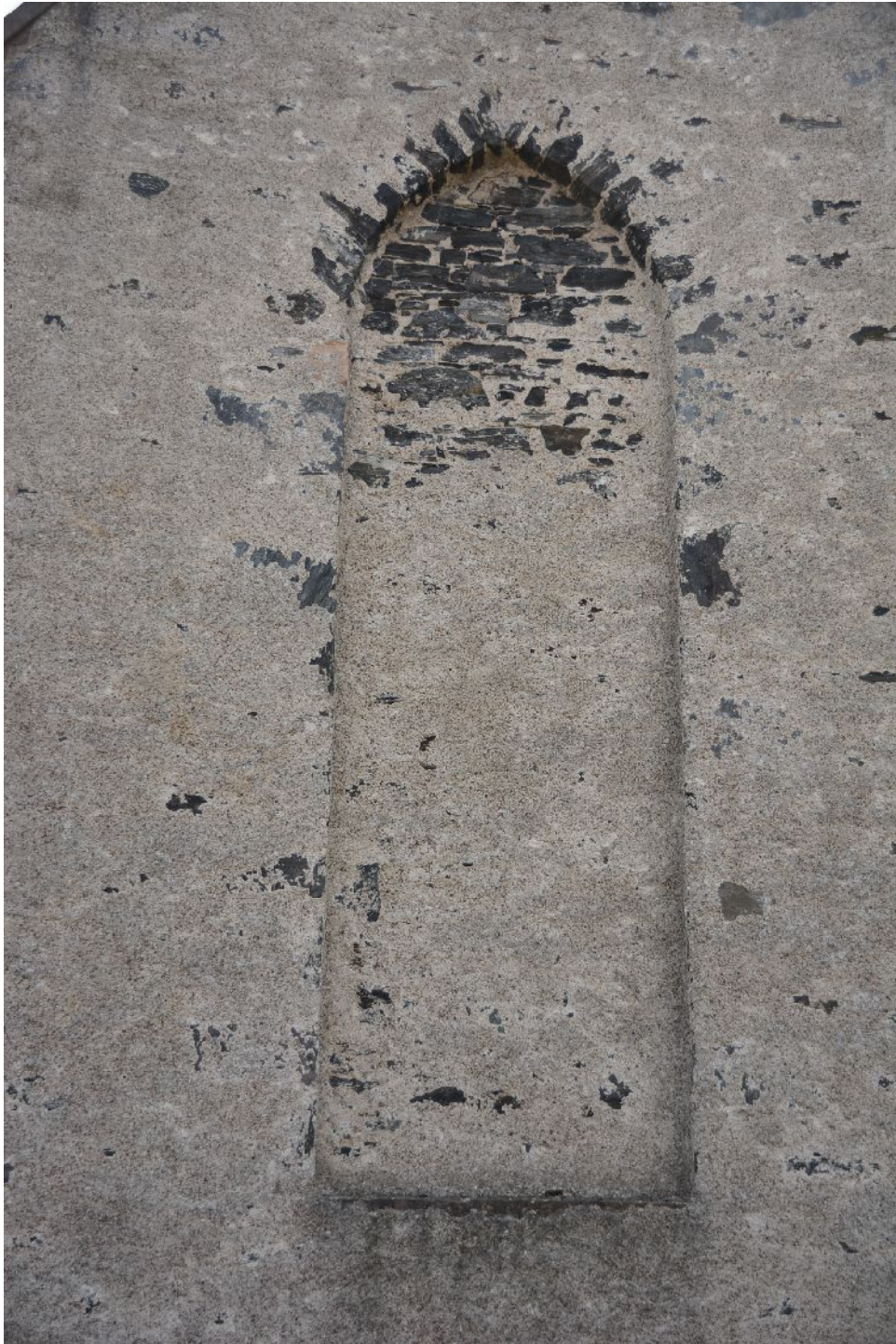
Illus 34 N wall. Detail of F1
