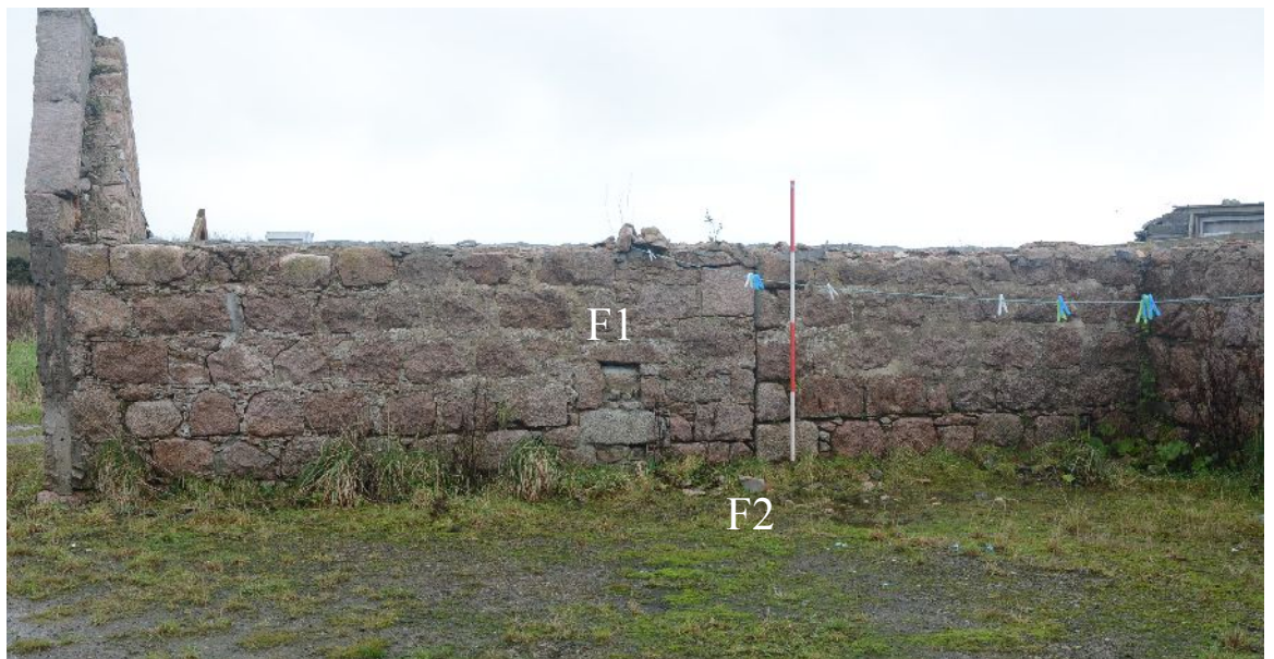
Illus 18 Building 2. F1 and F2 external.
