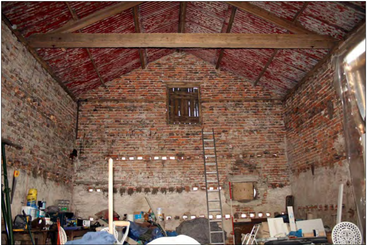
Plate 55. B5 interior looking NE (image no. 281).
