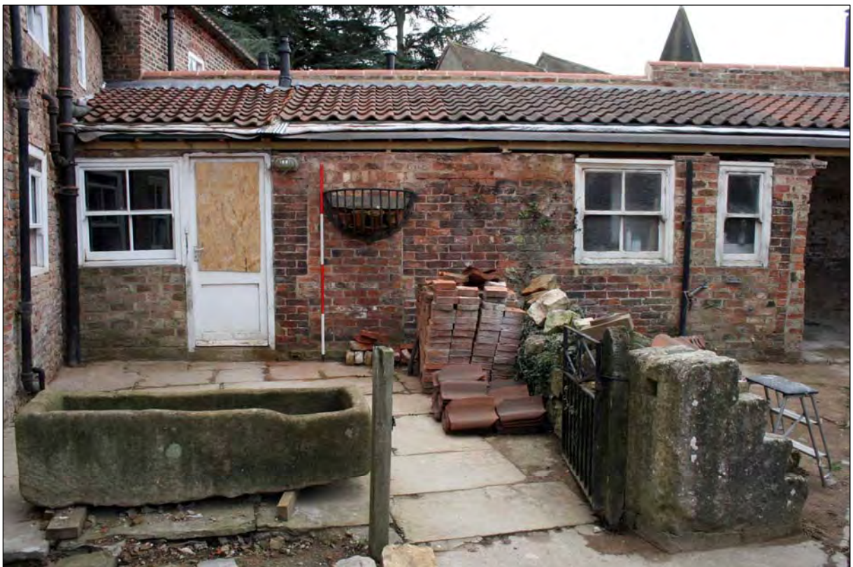
Plate 24. B2 exterior looking west (image no. 387).
