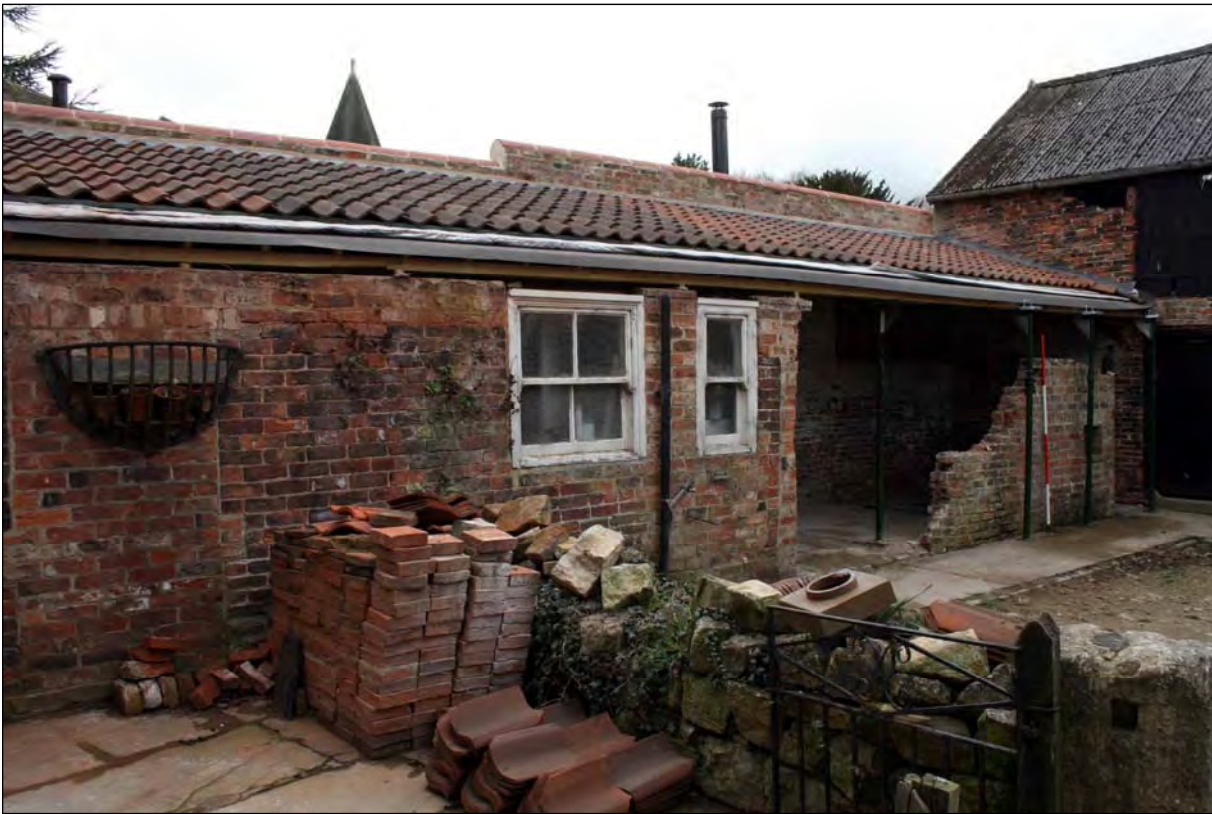
Plate 21. B2 exterior looking west (image no. 387).
