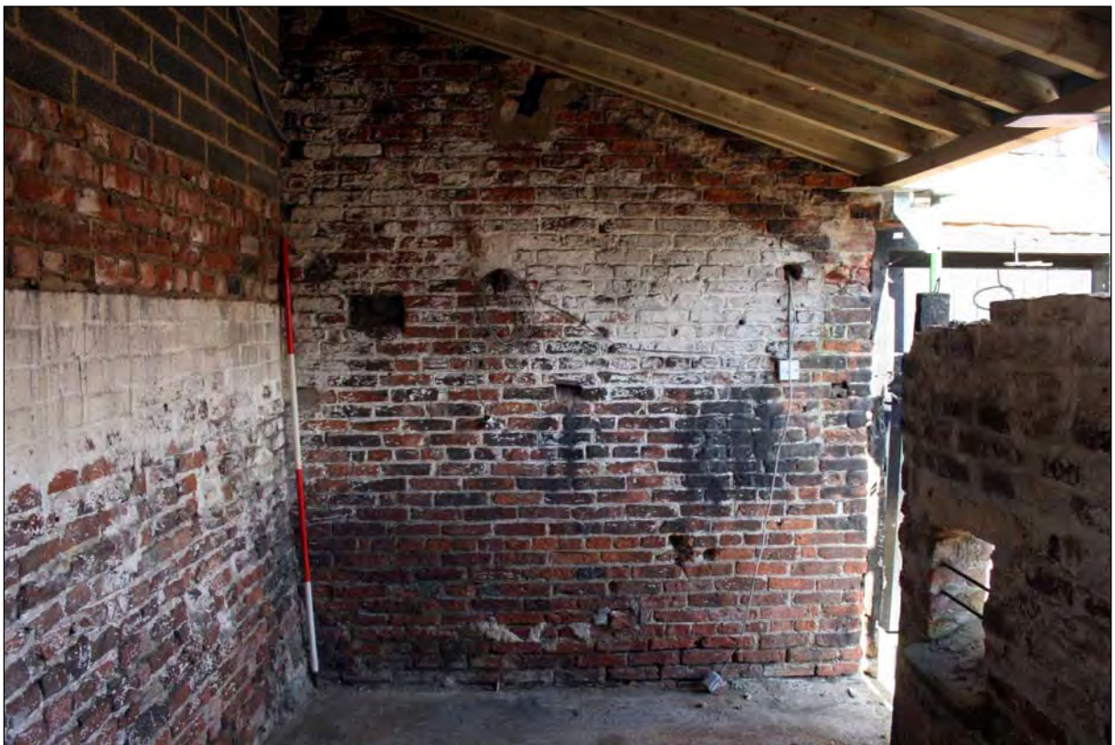
Plate 28. B2 interior NW looking NE (image no. 247).
