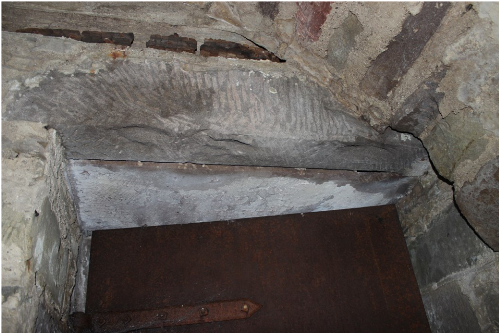
Illus. 56: Wooden lintel 056 above door 006 lintel.
