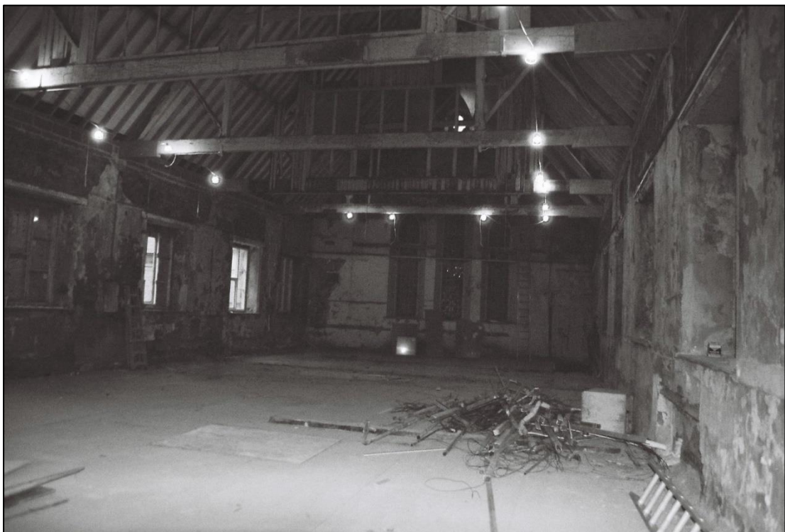
Plate 34: General view of Room F1 (Film/Frame 2.20)
