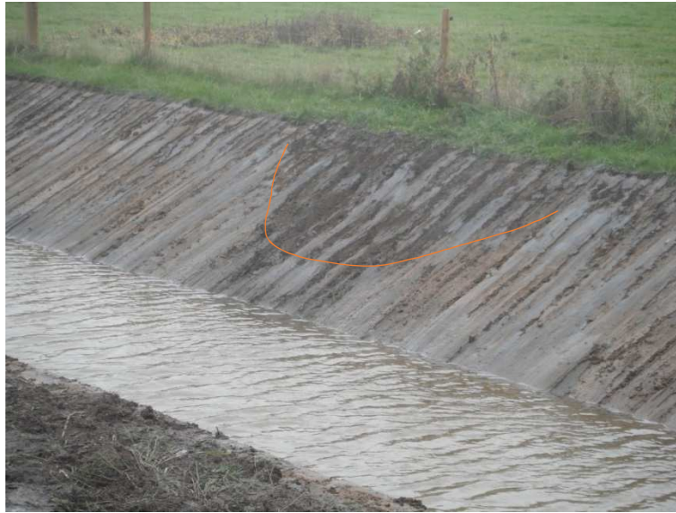
Plate 4. Site E: Ditch
