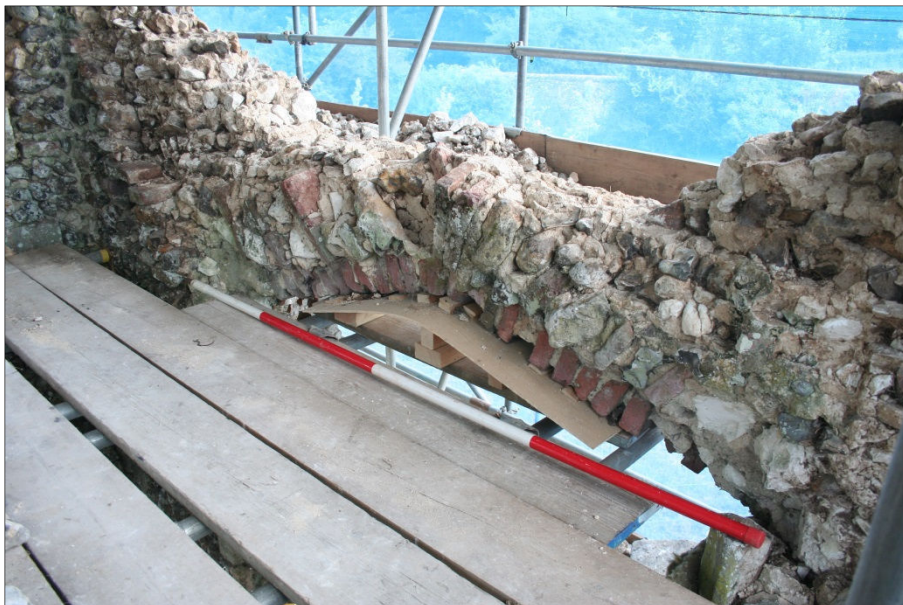
Plate 6: Window Arch 2 (N. Elevation) [1x2m Scale]
