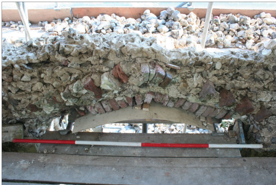
Plate 8: Window Arch 3 (N. Elevation) [1x2m Scale]
