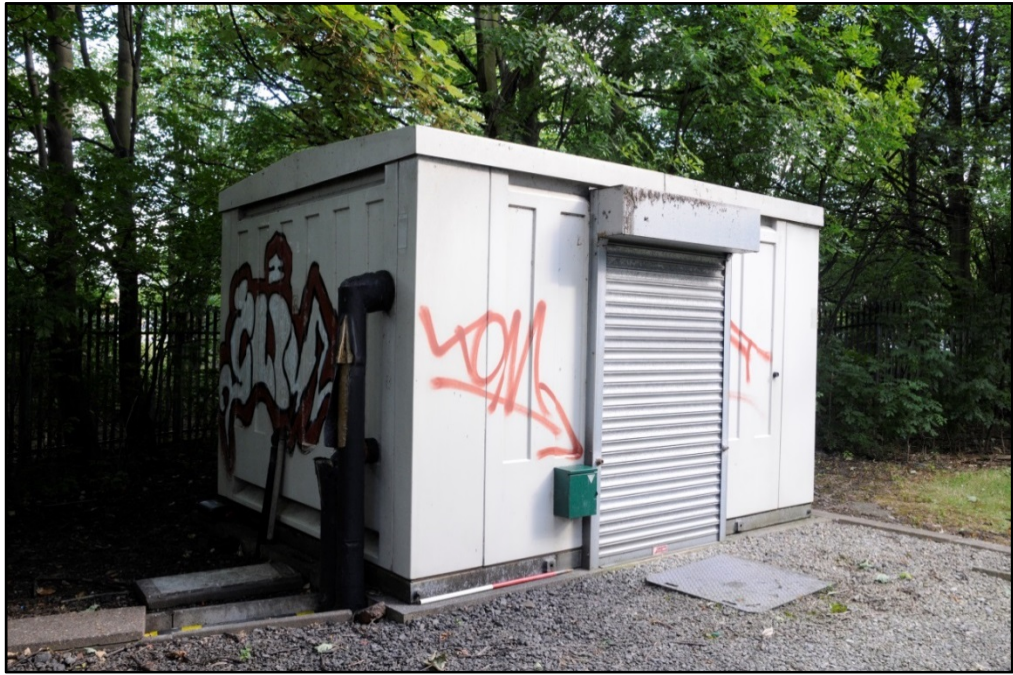
Kiosk structure 1 Fig 32
