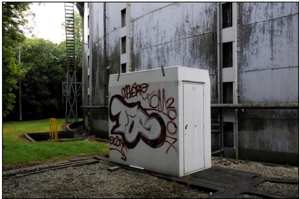
Kiosk structure 2 Fig 33
