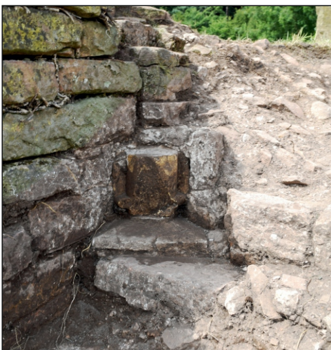
(d) The vaulting shaft, looking north
