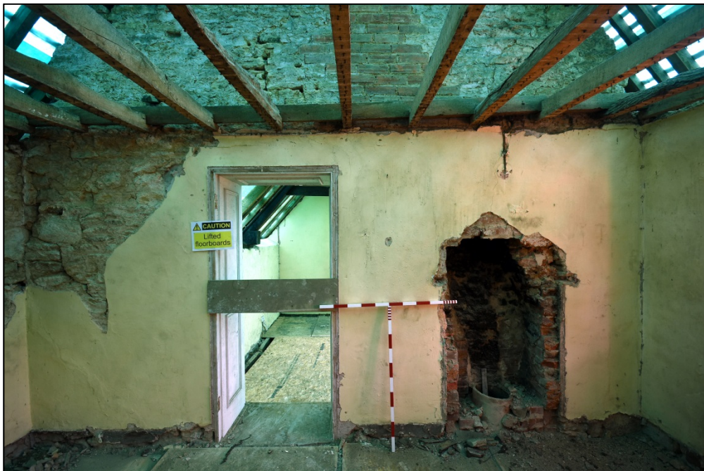
The east wall of room F1 Fig 39
