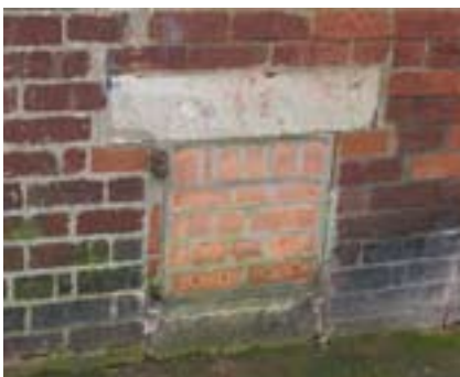
Fig 12: Raking-out hatch. (DPI46637)
