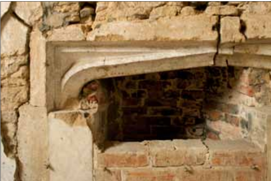
Fig 9. Spandrel detail of fireplace in N3.05. (DPI41238)
