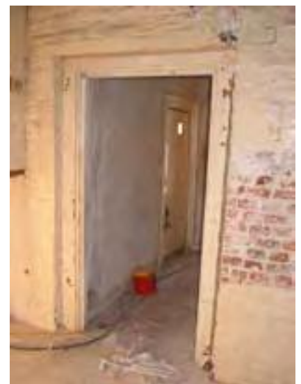
Fig. 50: Back door (DP070337).
