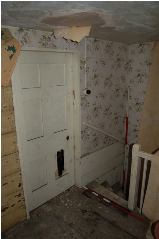
Plate 205: Bldg B, Block B7; door BF20/BF18.
