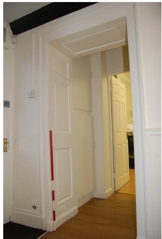
Plate 113: Bldg B, Block B1; door BG12-BG10.
