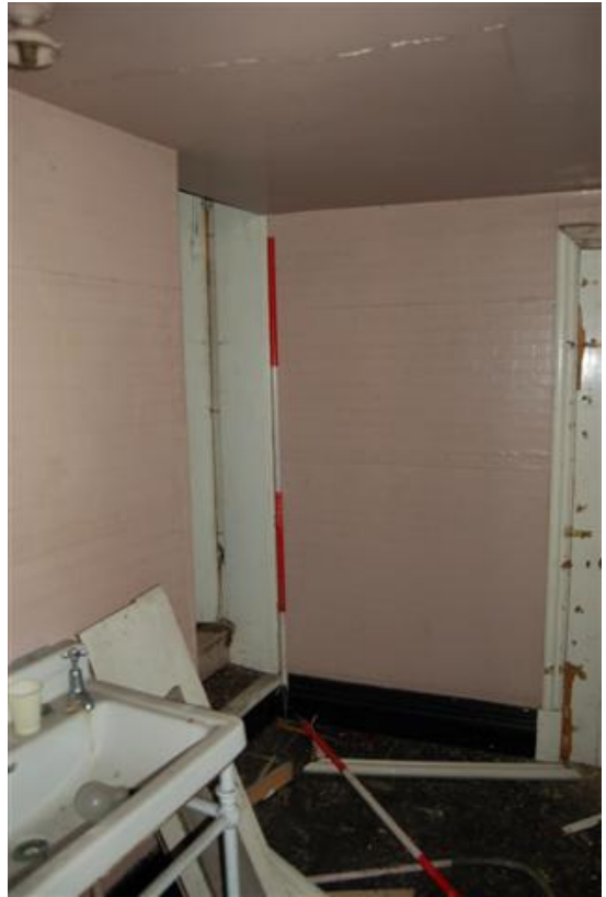
Plate 197: Bldg B, Block B7: Rm BF18 → S.
