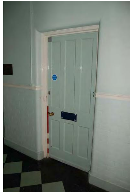
Plate 54: Bldg 28: GF door detail.
