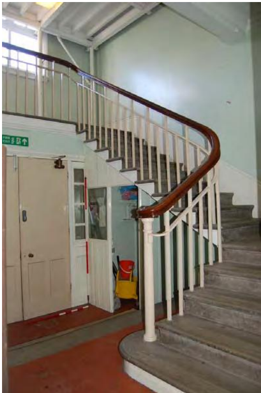
Plate 122: Bldg 37: main staircase (GF01).
