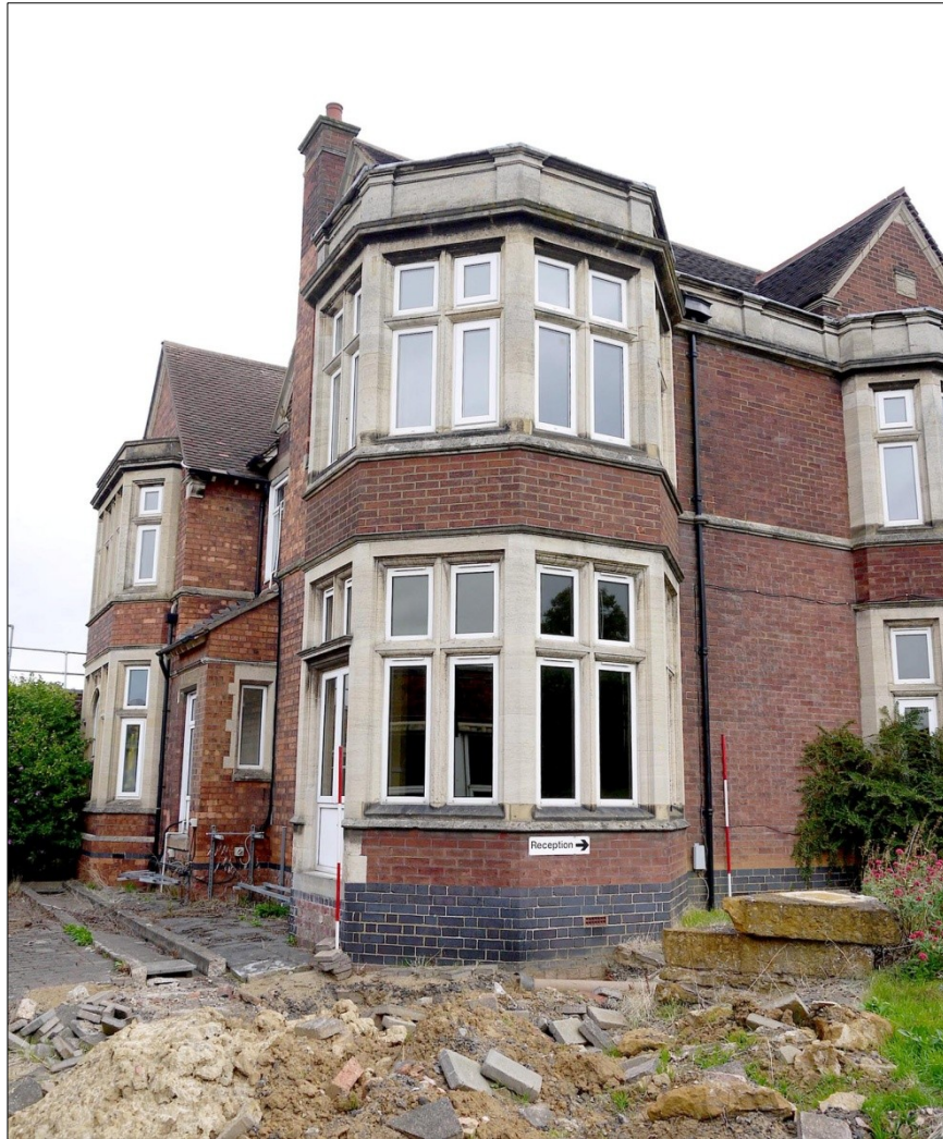
24. SW turret. Facing NE
