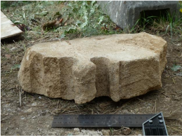
Fig 11: Photo of reused voussoir
