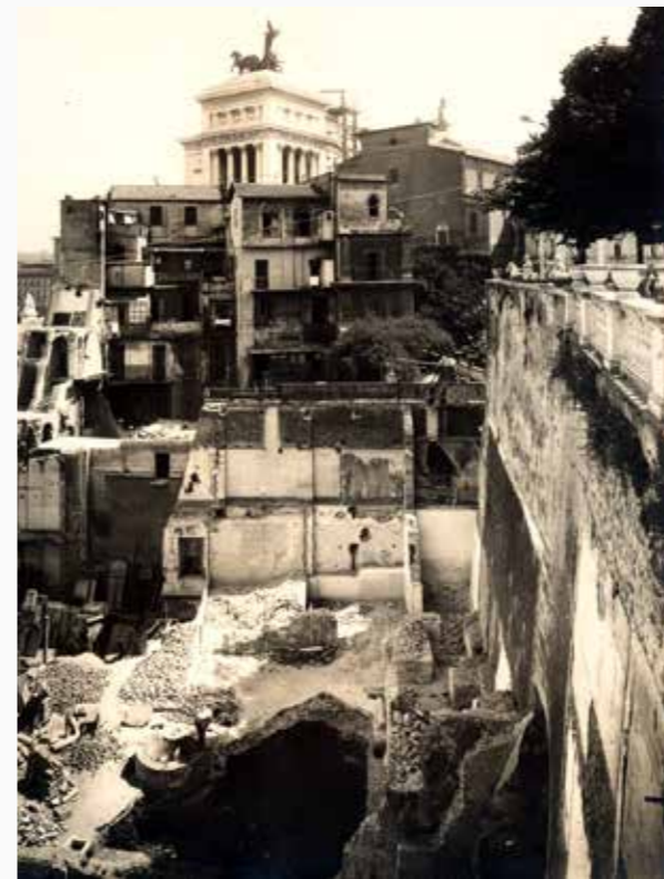
Fig. 3 Roma, sventramenti attorno al Colle del Campidoglio Rome, demolitions around the Capitoline Hill
