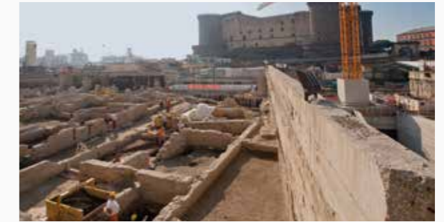
Napoli. Piazza Municipio. Scavi durante la costruzione della metropolitana Naples. Piazza Municipio. Excavations during metro constructions works
