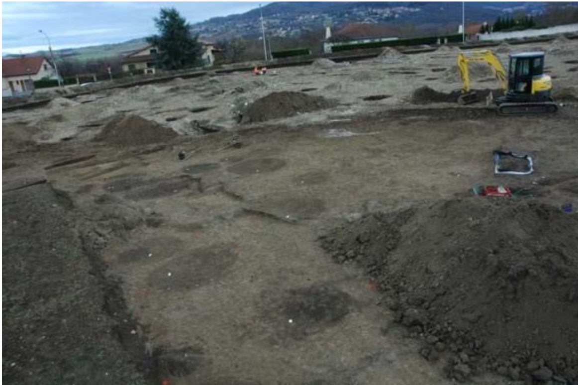
Base du décapage mécanique et densité des structures en creux, aucun répit n'est possible ! © Carine Muller-Pelletier, Inrap
