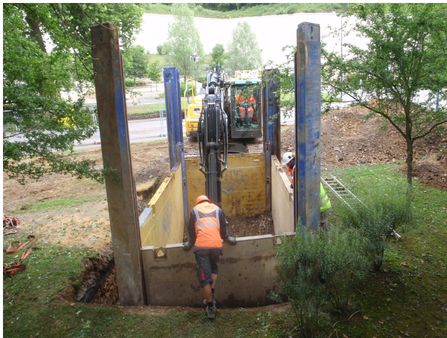
Réalisation d'un sondage profond blindé sur le diagnostic de Verdun © Luc Sanson, Inrap
