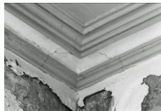
Frame 37: SW cornice
