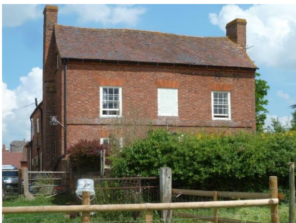
3 windows (centre blocked).
