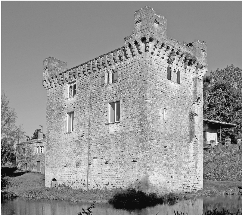
Fig. 17. Moulin de La Salle à Cleyrac (Gironde). Photograph: Vincent Joineau.
