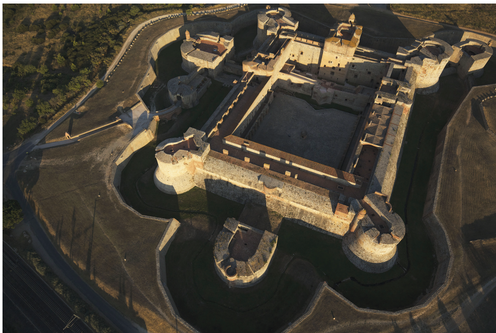
ILLUS 13 The transitional fort de Salses, Salses-le-Chateau, view from the east (RMW17-0109, 2017) (© Rémy Marion / Pôles d'images / Centre des monuments nationaux)
