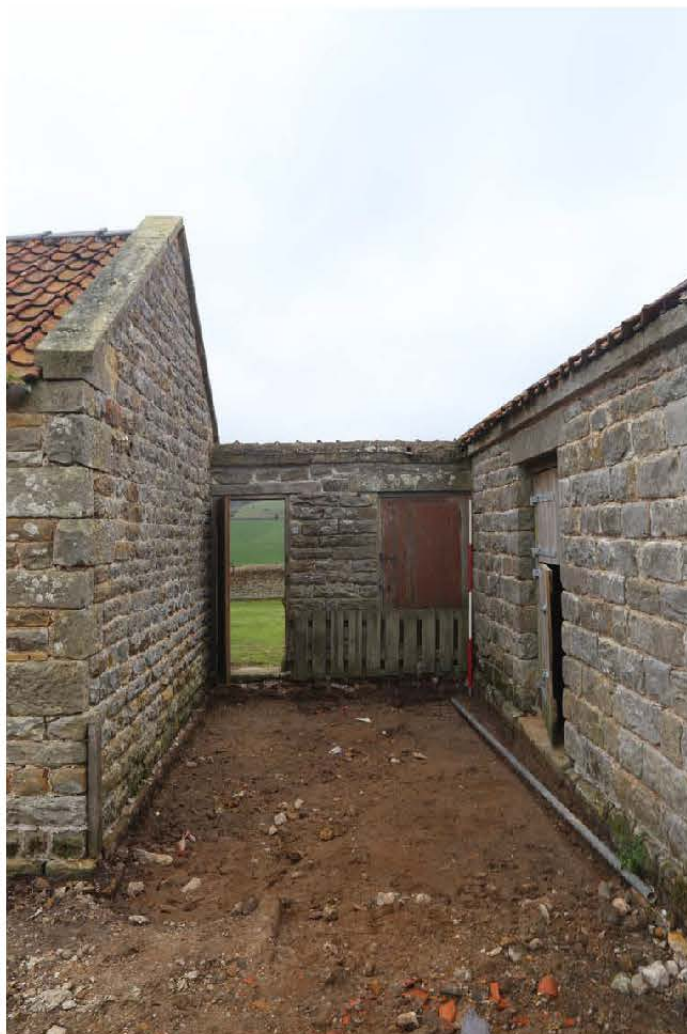
047_1050_boundary wall and door
