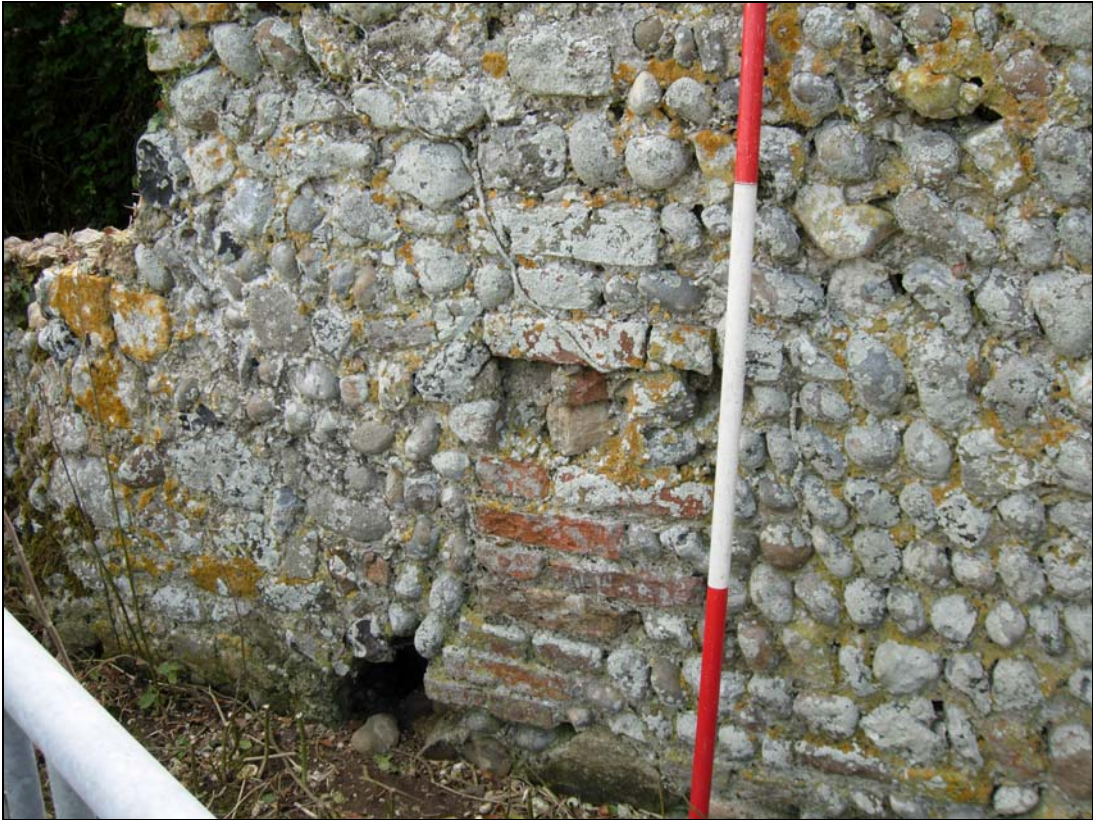
Plate 61. S. precinct wall: S. end, vertical brick element
