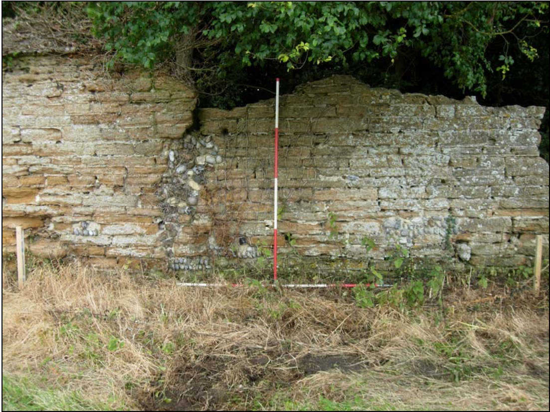
Plate 23. E. precinct wall: Stint 60 – 65m
