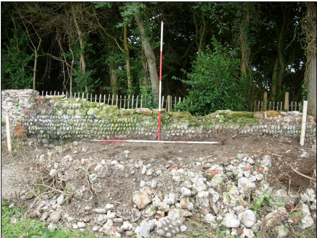
Plate 16. E. precinct wall: Stint 25 – 30m
