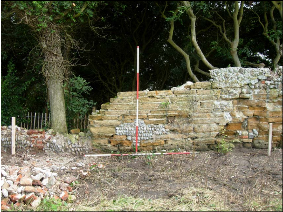
Plate 17. E. precinct wall: Stint 30 – 35m
