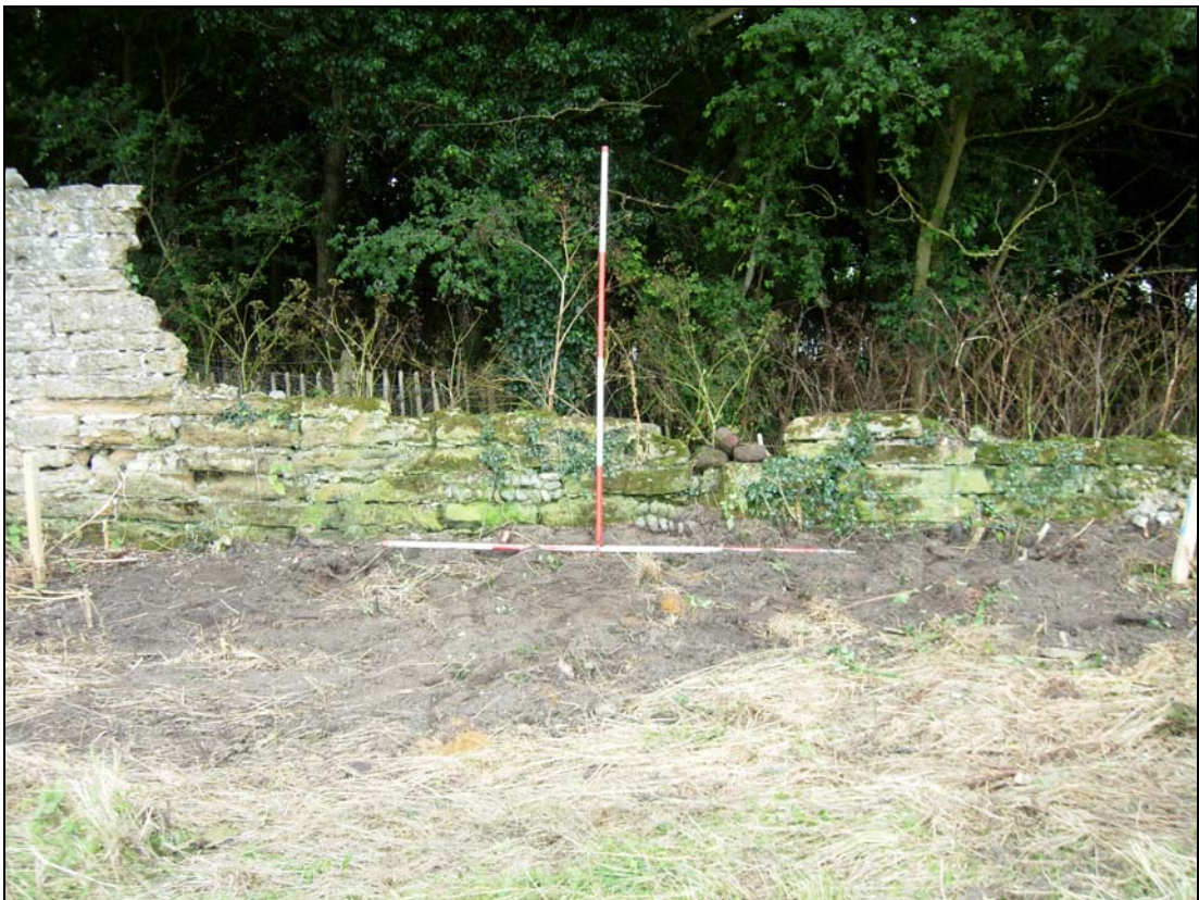
Plate 24. E. precinct wall: Stint 65 – 70m
