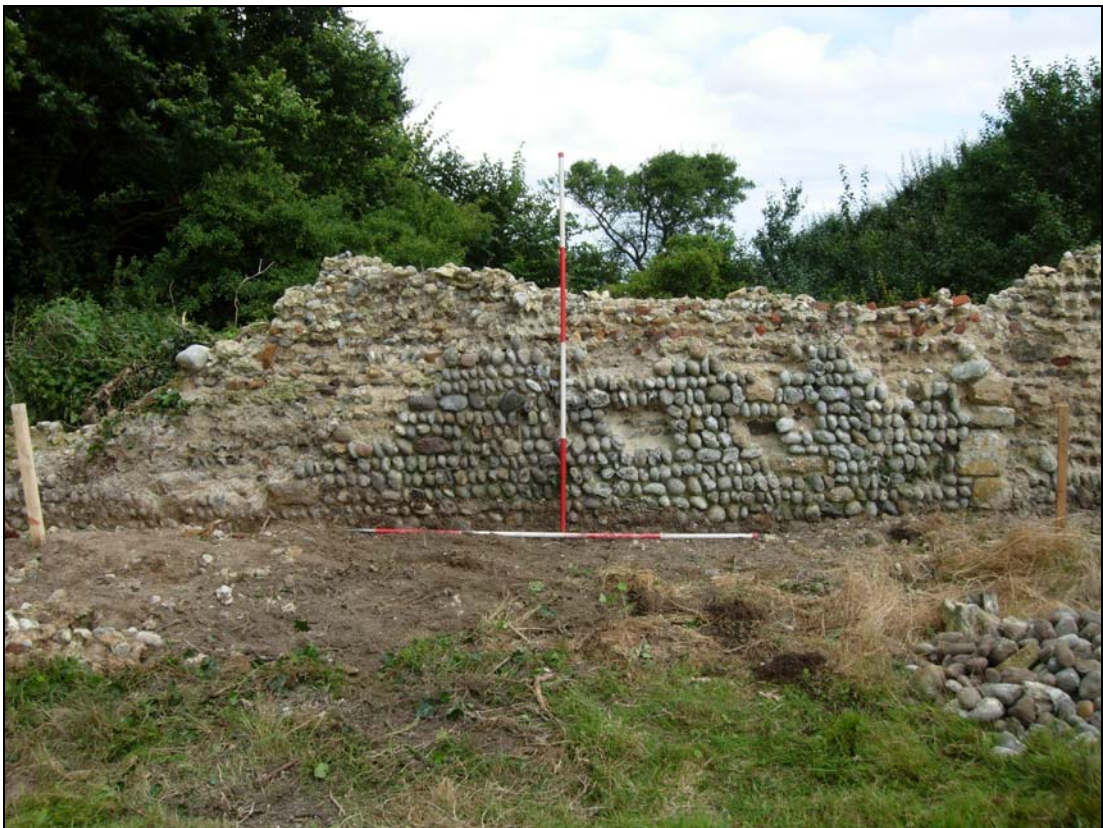
Plate 30. E. precinct wall: Stint 95 – 100m
