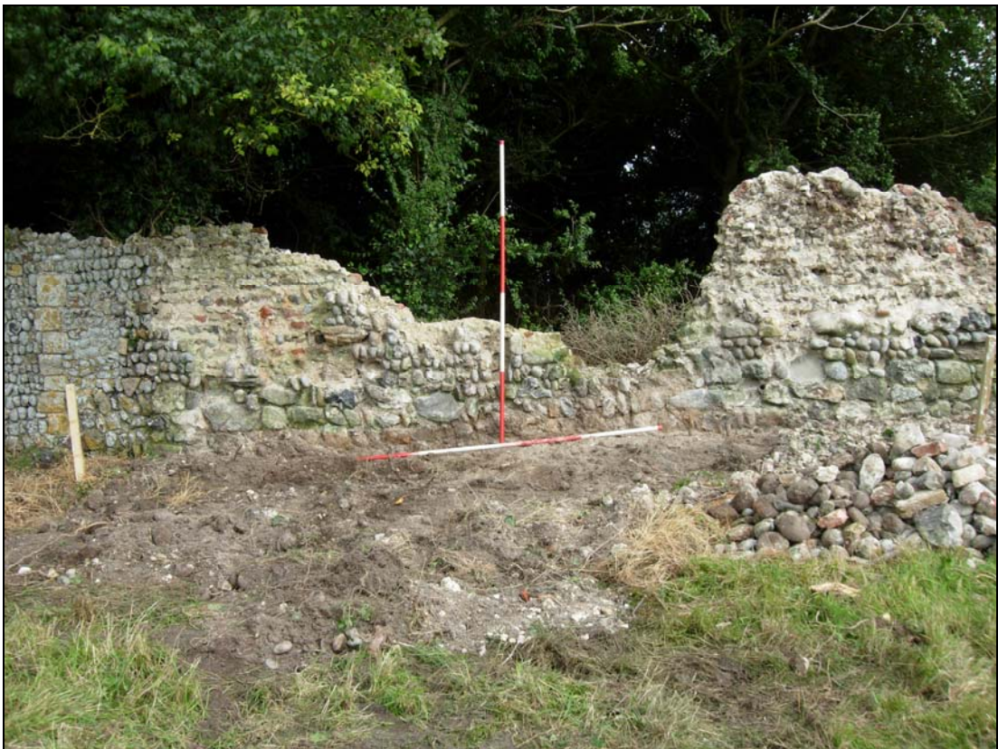
Plate 28. E. precinct wall: Stint 85 – 90m
