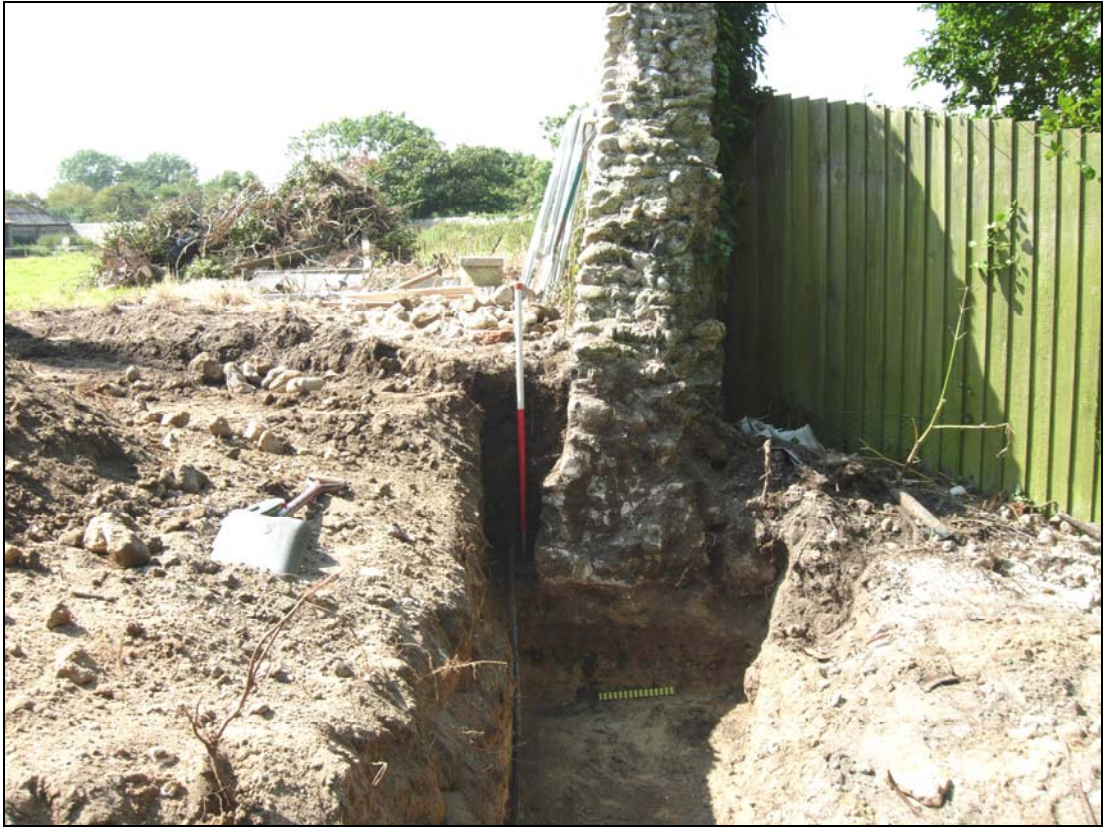
Plate 3. N. precinct wall: S1
