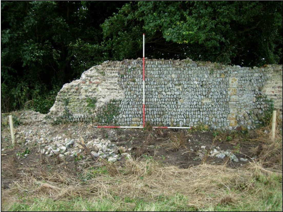
Plate 27. E. precinct wall: Stint 80 – 85m
