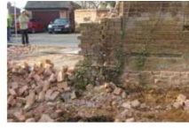
XA20 2015 demolition (3).JPG
