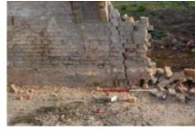
XA20 2015 demolition (2).JPG
