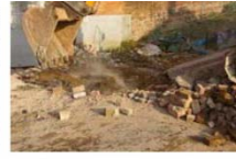
XA20 2015 demolition (4).JPG
