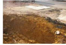
XA20 2015 demolition (9).JPG
