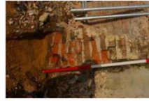
XA20 2015 demolition (8).JPG
