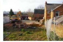
XA20 2015 demolition (10).JPG
