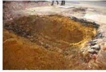
XA20 2015 demolition (6).JPG
