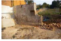
XA20 2015 demolition (1).JPG
