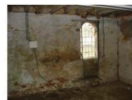
GFir N room (4).JPG
