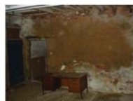
GFir N room (2).JPG
