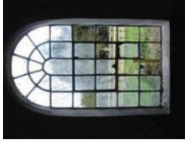
GFlr Stairs (6).JPG
