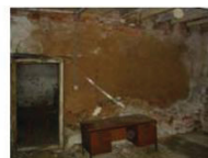
GFir N room (3).JPG
