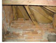
GFlr Stairs (2).JPG
