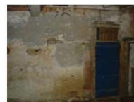
GFir N room (5).JPG
