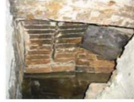
GFlr Stairs (5).JPG
