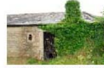
NE 9 Door and Chimney.jpg
