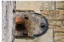
SE 9 Door 1 detail 2.jpg
