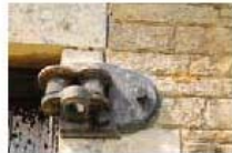
SE 8 Door 1 detail 1.JPG
