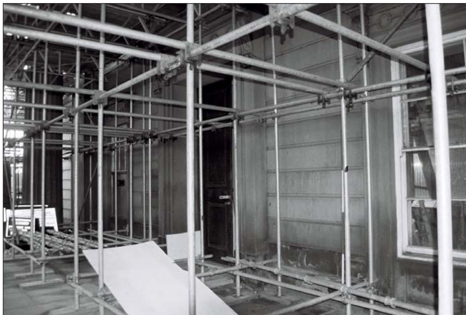
○ 階段のコンクリート打設完了後、階段の養生を撤去し、階段の清掃を行った。
