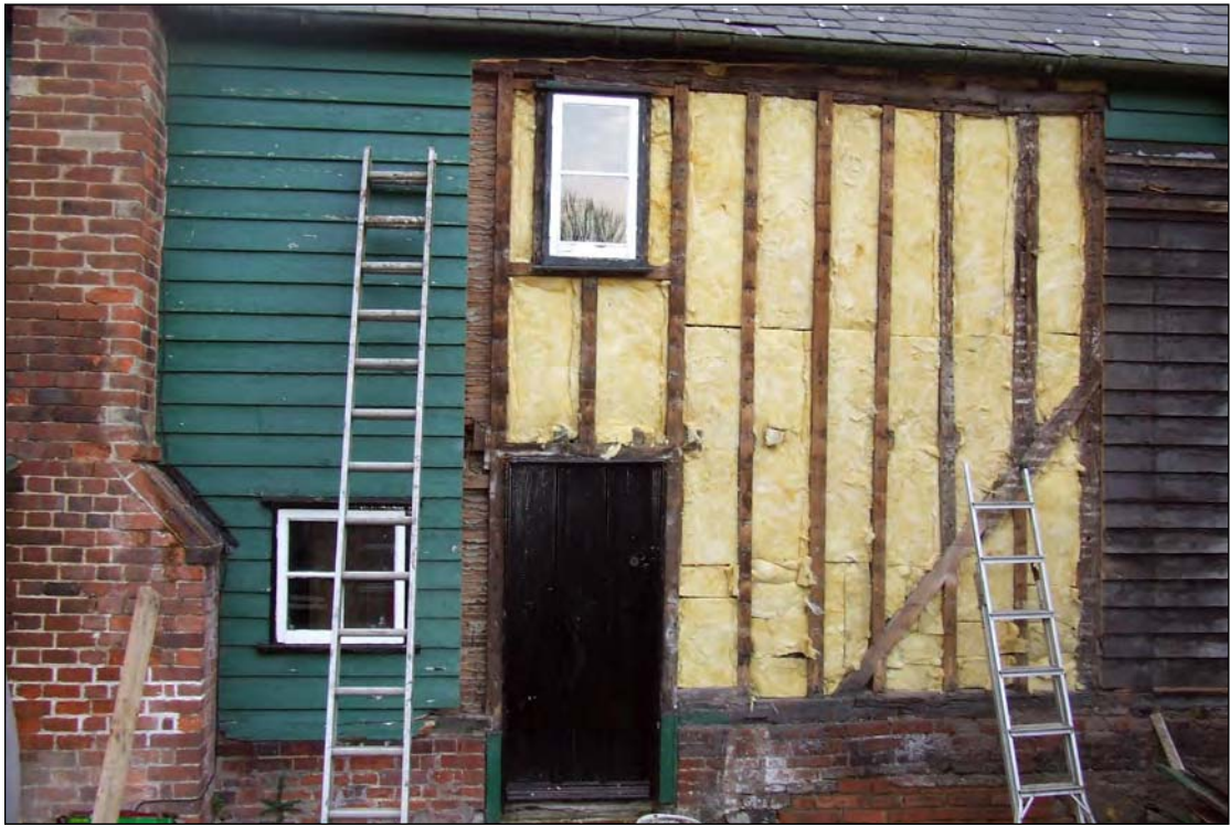
late : i er fra e in filled ith insulation
