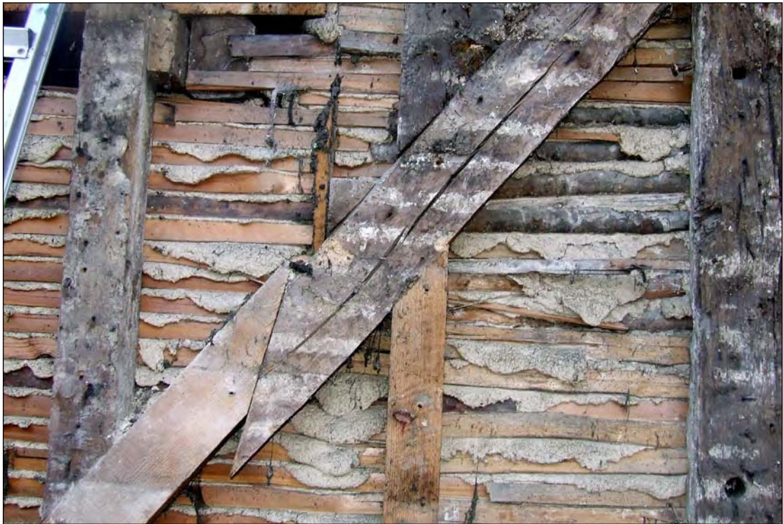
late : epaired ra e
